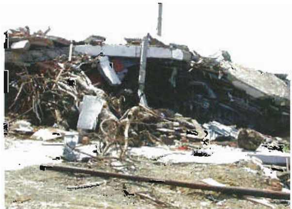
写真6 住宅の土台の下に押し込まれた樹木と瓦礫
