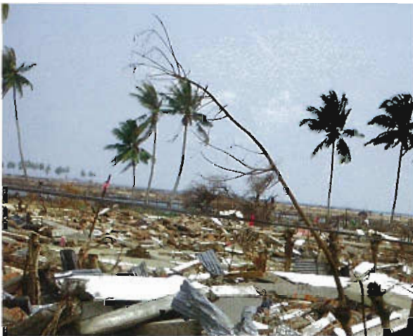
写真8 瓦礫の山と化したリゾートホテルや住宅街
